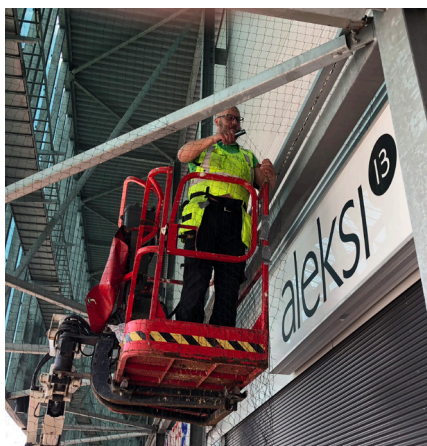
Ideaparkin lintuverkkojen asennusta.
